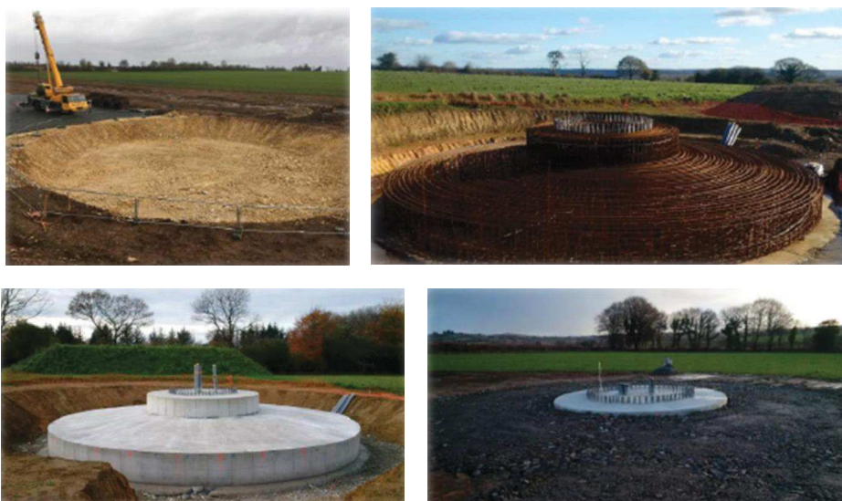
Figure 24 : Mise en œuvre d'une fondation (Source : ENERCON)
