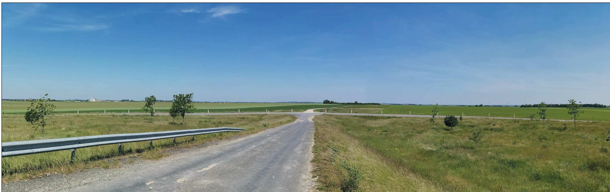
Vue 20 : Vue panoramique depuis le sud de la ZIP, au « Pont aux Bois », en direction du nord.
