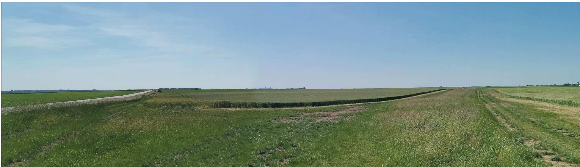
Vue 12 : Vue panoramique depuis la RD94 au nord de l'AEI, en direction du sud, vers la ZIP.
