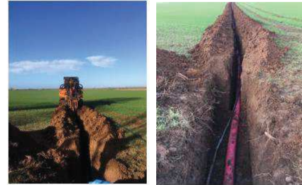
Figure 26 : Réalisation de la tranchée et de la pose du câble (Source : ENERCON)
