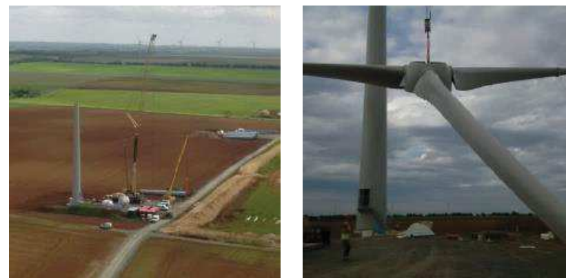
Figure 25 : Montage du mât (à droite) et levage du rotor (à gauche) (Source : ENERCON)
